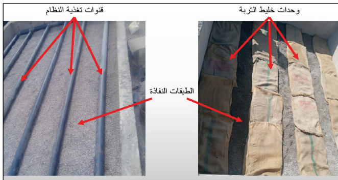
شكل 4. أحد تطبيقات نظام المرشحات المتداخلة لمعالجة المياه المنزلية العادمة بمدينة مراكش، المغرب.
