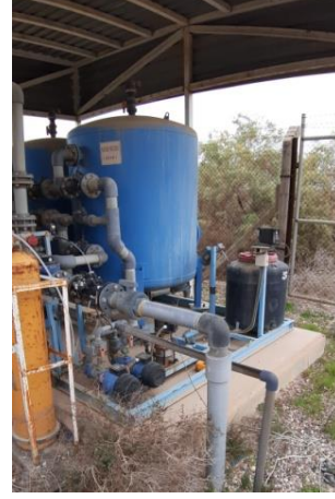
صورة رقم 13-3: مضخات سحب الاطيان في محطة الترابه
