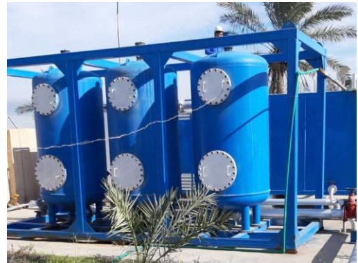
صوره رقم 11-3:المرشح ذو الطبقات في مشروع تحلية المياه السودان 35م 3 /ساعة
