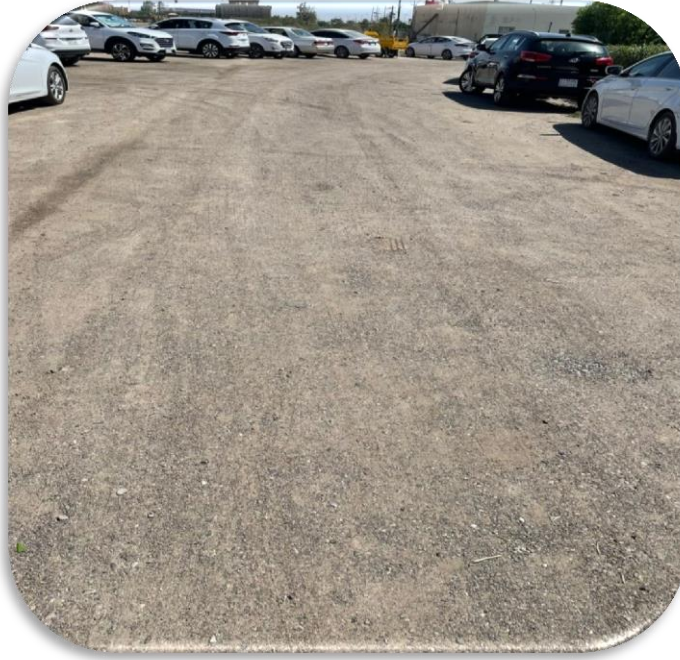
الطريق المؤدي لمبنى العمادة ووقوف السيارات A- 1
