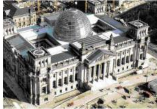
Şekil 42. Reichstag Parlamento Binası çatı bütünleşik pv (photovoltaik panel) sistem (URL 22)
