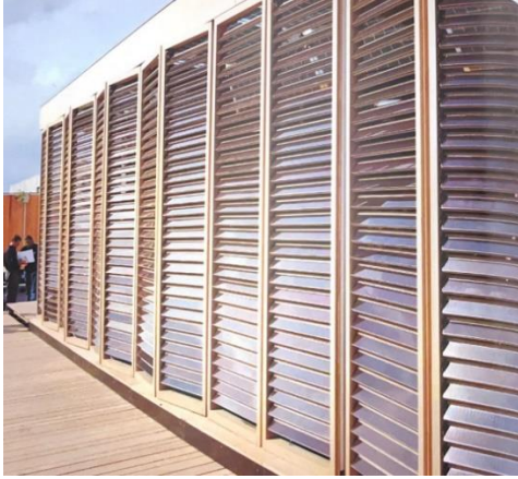
Şekil 31. Kepenlerdeki ayarlanabilen fotovoltaik paneller, (M. Guzowski, 2019)
