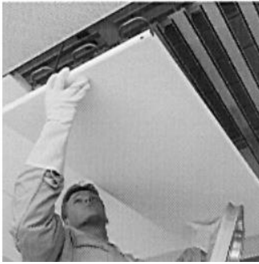
Şekil 36. Sistemin panellerle birlikte kaplanması (URL 18)
