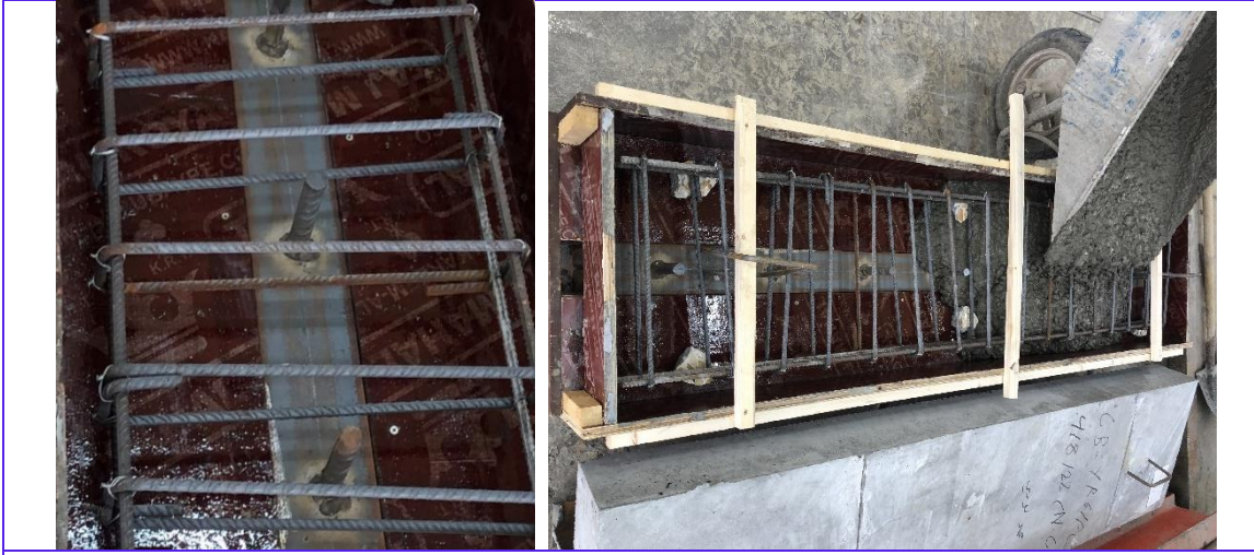
Fig.7 Rebar Ø 20 mm (Stud Shear).
