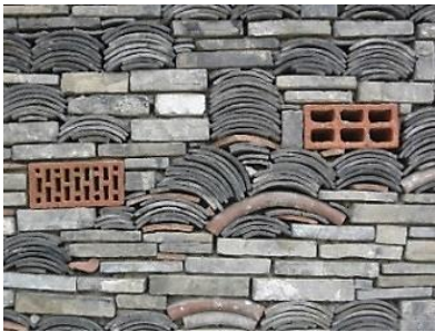
شكل (2): متحف نينغبو Ningbo التاريخي، مصنوع من الركام المحلي بطريقة تسمى "وا بان". المصدر: (Architecture | Wang Shu's Ningbo ) (Museum | CFile – Contemporary Ceramic Art + Design (cfileonline.org))
