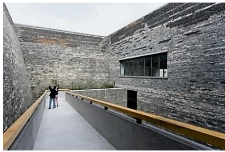
شكل (2): متحف نينغبو Ningbo التاريخي، مصنوع من الركام المحلي بطريقة تسمى "وا بان". المصدر: (Architecture | Wang Shu's Ningbo ) (Museum | CFile – Contemporary Ceramic Art + Design (cfileonline.org))
