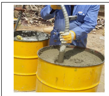
الشكل (٢) نقل النفايات داخل الكبسولة واطافة الخرسانة
