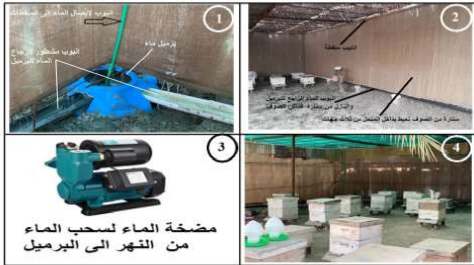
الشكل 3. مكونات منظومة التبريد الداخلية للمنحل
