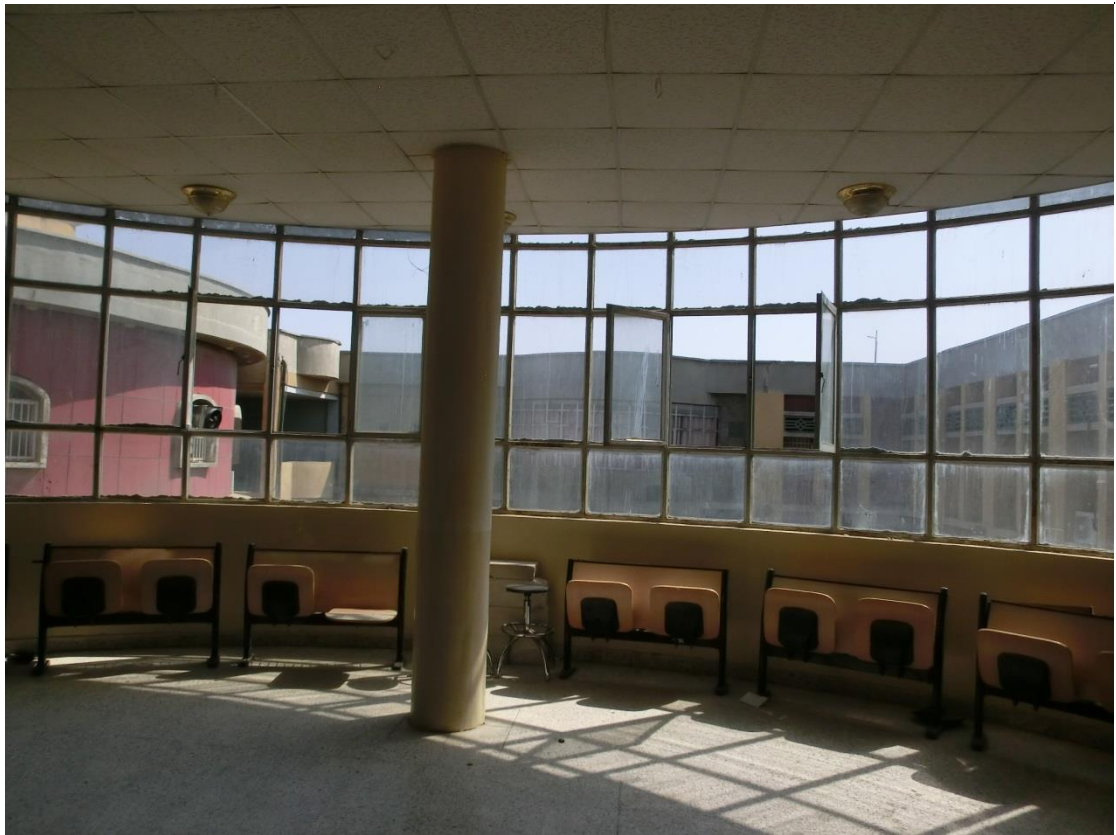
شكل رقم (١٠) يوضح الواجهة المزججة لبناية الهندسة المعمارية من الداخل
